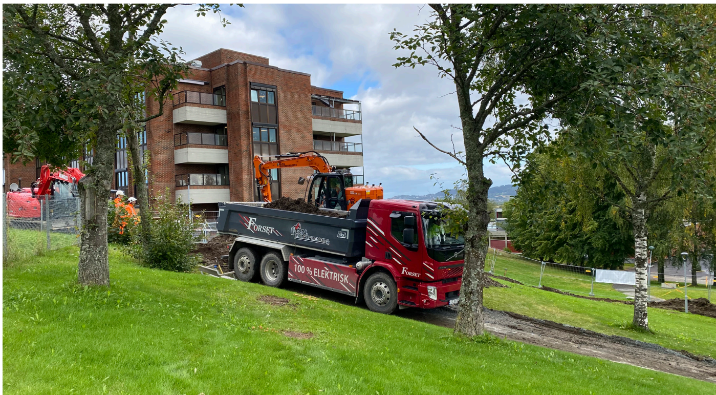
Elektrisk lastebil på snarveiprosjektet
