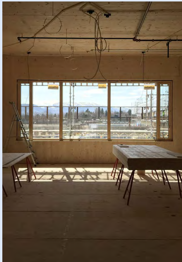
Bilder fra bygginga av de nye skolene på Huseby.
